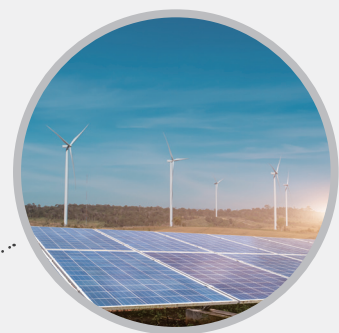
태양광발전설비 (모듈, 인버터 등)
